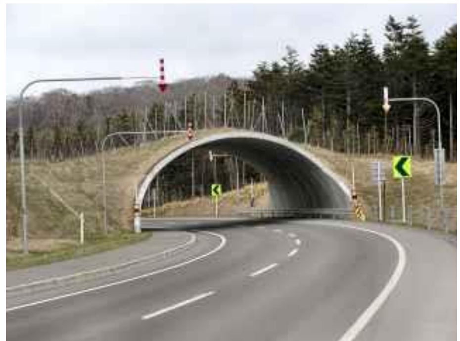
Puente sobre carretera para ciervos (Shyari-cho)
